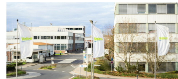
Abbildung 15: Valeo Bürogebäude (Valeo, o. J.)
